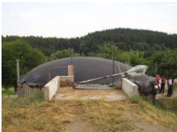
Image 1: Digesteur équipé d'un stockage souple (membrane EPDM) avant la test au feu.
