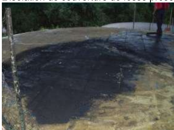
Image 21: Test au chiffon imbibé d'essence: Vue sur la couverture de la fosse débarrassée des restes de la membrane.
