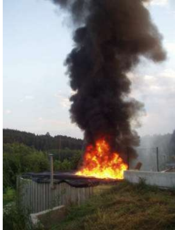
Image 15 + 16: le biogaz existant s'est complètement consumé, le feu s'attaque à l'isolation de la couverture
